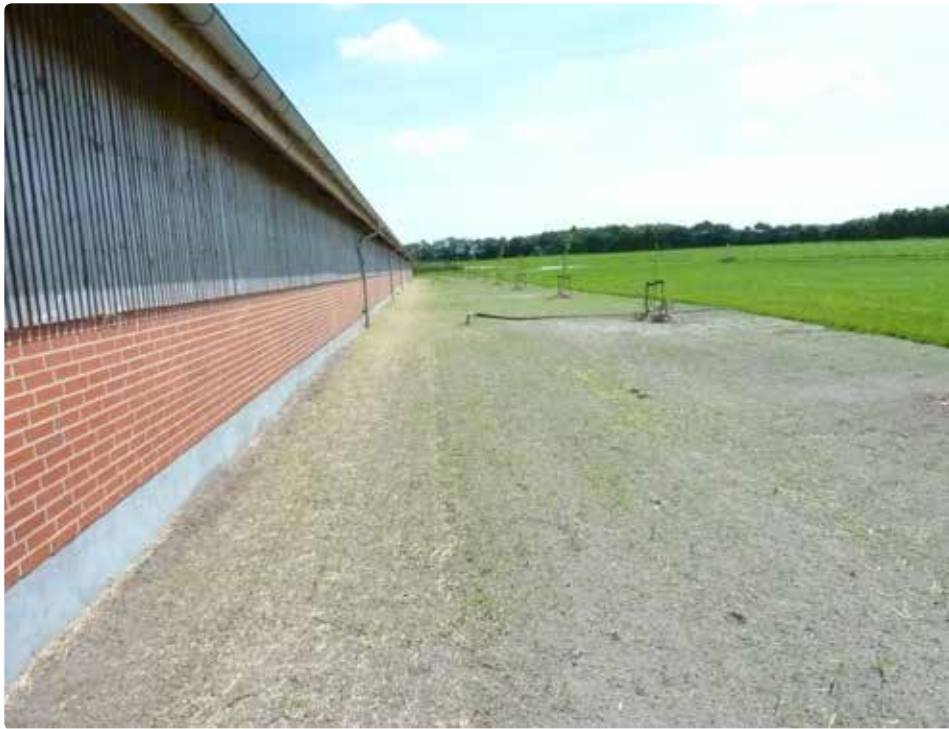
Billede 4. Hydrant og løs slange til sprinkler.
