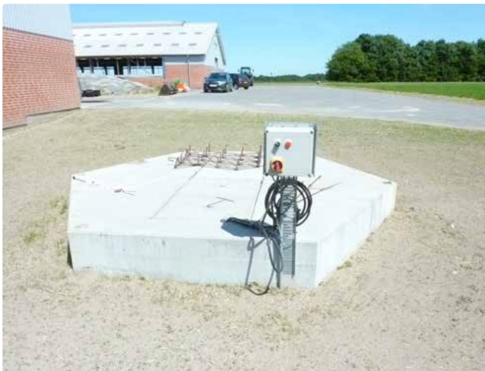
Billede 5. Opsamlingstank med pumpe og strømforsyning.
