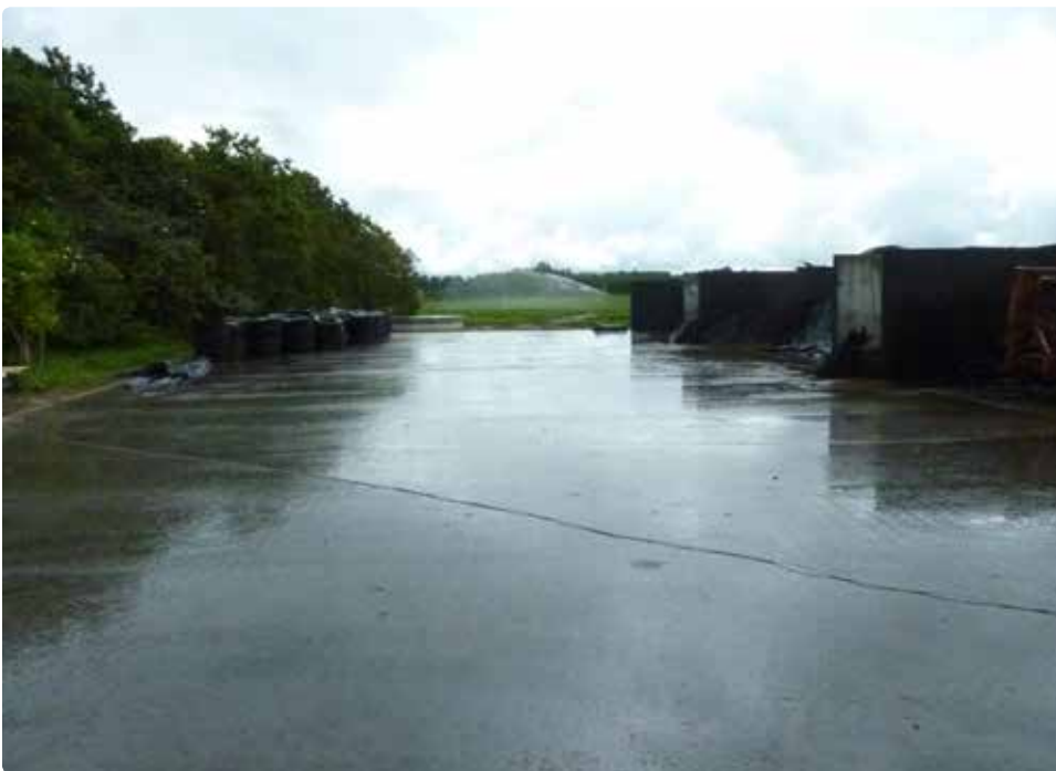
Billede 7. Forplads og sprinklere i baggrunden.
